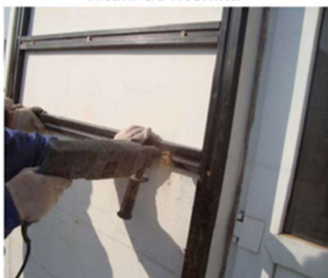
Vrtání do nosníku
