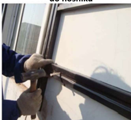
① Upevnění plastové hmoždinky do nosníku
